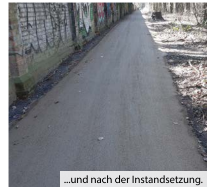
...und nach der Instandsetzung.
