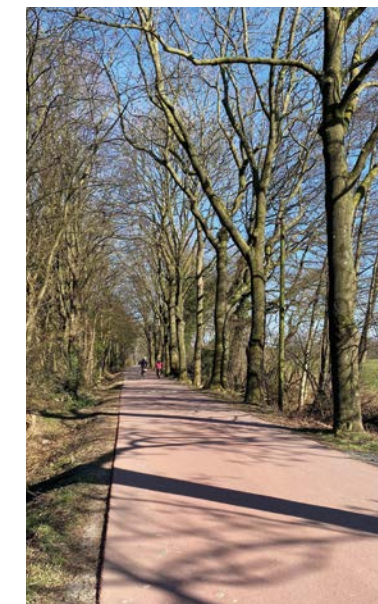
Ende 2022 soll die Beleuchtung fertig sein und die Dingstiege kann auch bei Dunkelheit von Radfahrenden sicher genutzt werden.
